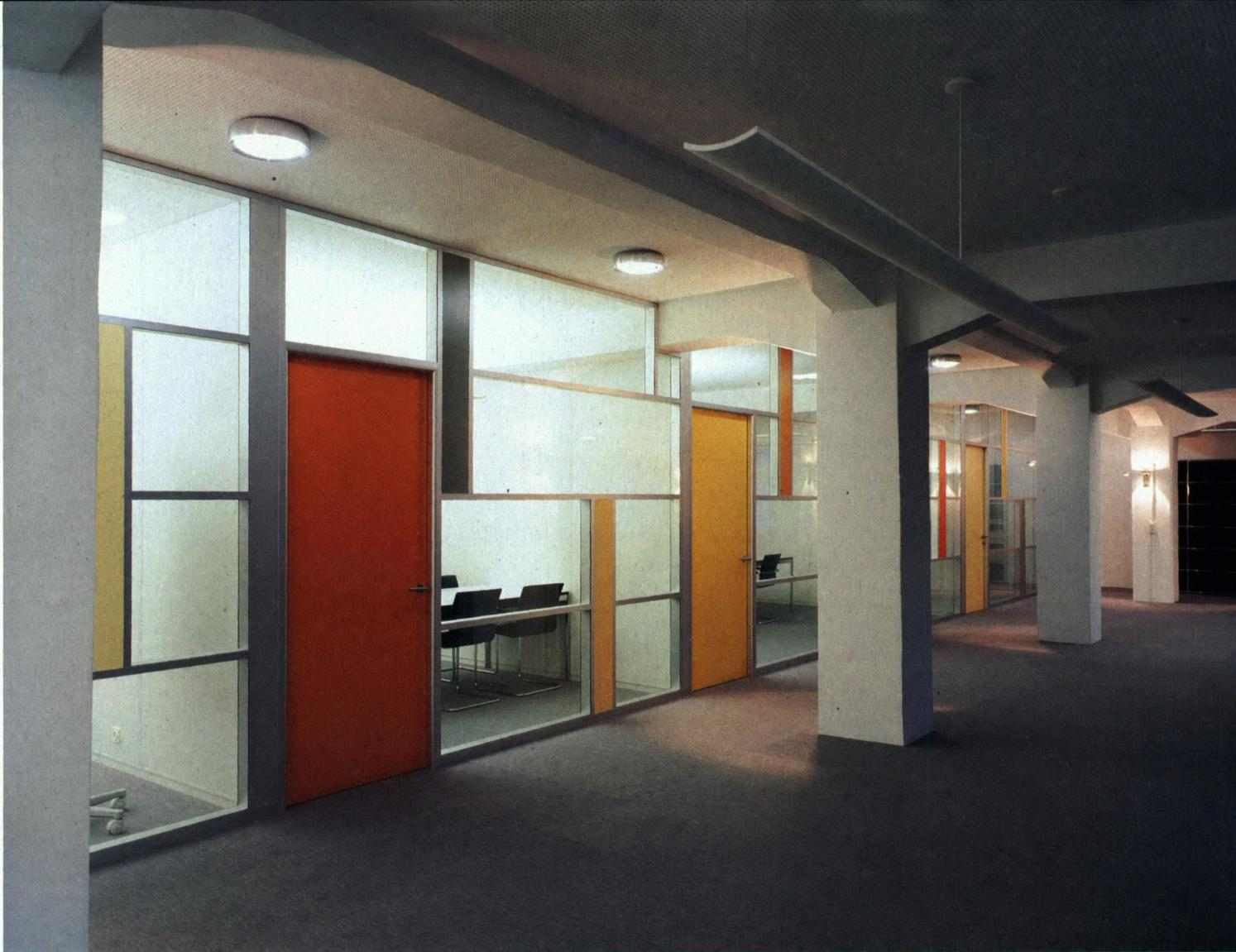
Links oben: Die unteren Gläser tragen die oberen, die Leisten fixieren lediglich die Position der Gläser. Das ermöglicht die freie geometrische Gestaltung der Glaswand
