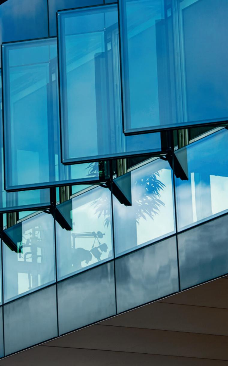
*Sorgt für ein exzellentes Raumklima, funktioniert vollautomatisch und sieht auch noch gut aus: eine Fassade, die technologisch und ästhetisch alles Gewohnte in den Schatten stellt.*
